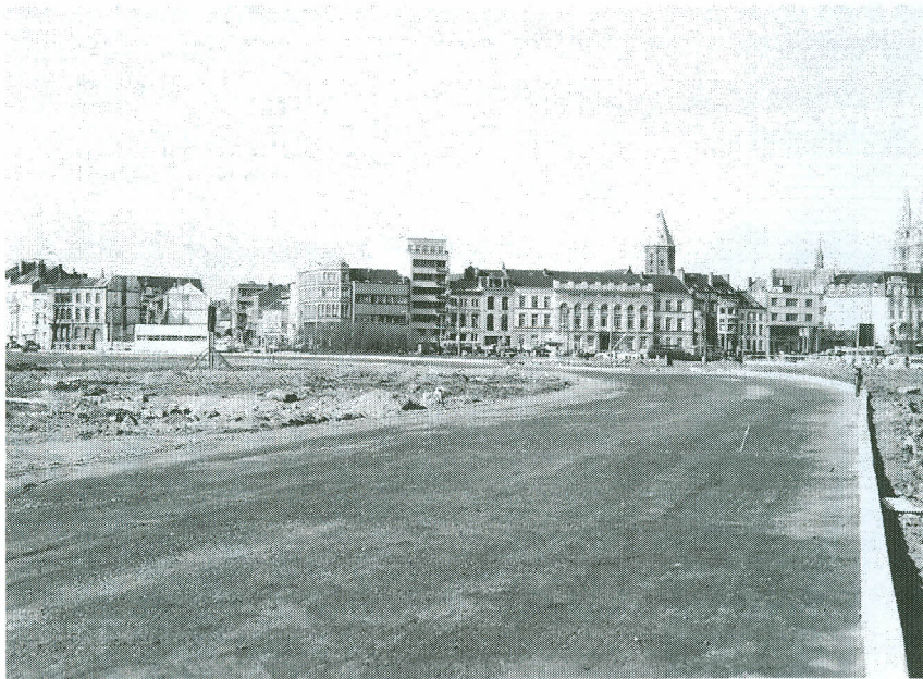
Fig. nr. 198. Oostende 05 mei 1954. De aanleg van de eindstrook van de autosnelweg Oostende-Brussel op het gedempte 3 e Handelsdok en op het voormalig tracé van de treinsporen van het spoorwegstation Oostende-Stad. Bemerkt de Vindictivelaan met het "O.L.Vr.-College" en de aanzet van de Hendrik Serruyslaan. Het "Kanonhotel" is gesloopt en de wederopbouw is nog niet voleindigd.
