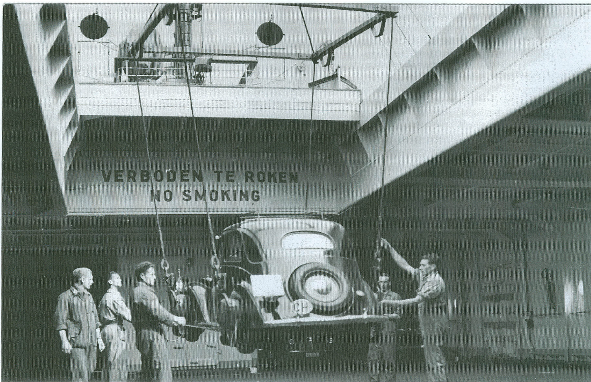
Fig. nr. 201. Haven Oostende, 1949. Het laden doorheen het luikhoofd van auto's op de carferry "Prinses Josephine Charlotte", door middel van één van de portaalkranen van de Pakketbotenkaai. Het laden en lossen van voertuigen door middel van een portaalkraan was een risicovol manoeuvre en vergde veel vakmanschap en mankracht, voornamelijk om te beletten dat de voertuigen schade opliepen.
