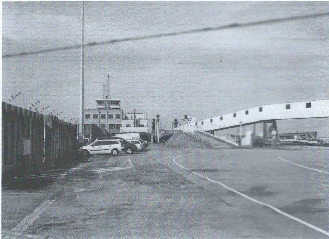
Fig. nr. 240. Haven Oostende, 2012. De zijlaadinstallatie aan carferrybrug 1. Rechts de carferrybrug met (in 't wit) de drukluchtketel voor de bediening van carferrybrug 1 . Bemerkt de passagierskoler gebouwd door Hoverspeed-Holyman.
