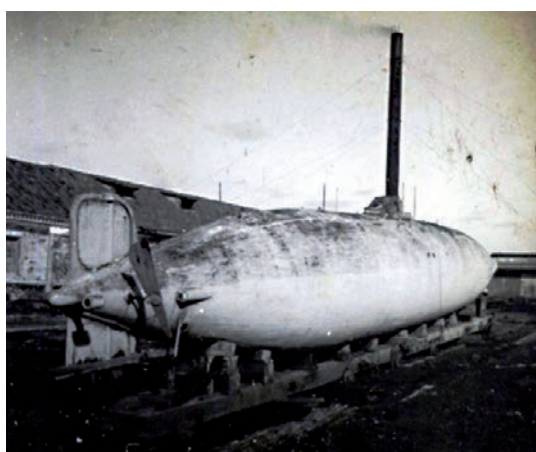
Figura 3. Submarino Peral abandonado en el Arsenal de La Carraca.
