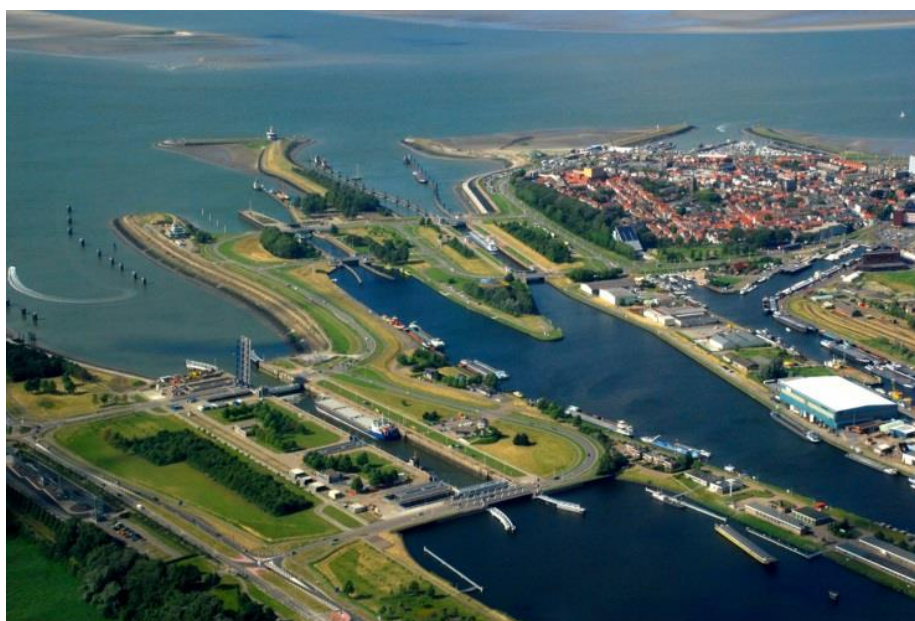
Figuur 3.2 overzicht sluizencomplex Terneuzen
