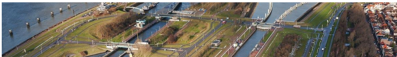
Figuur 1.5 Luchtfoto van het sluizencomplex Terneuzen
