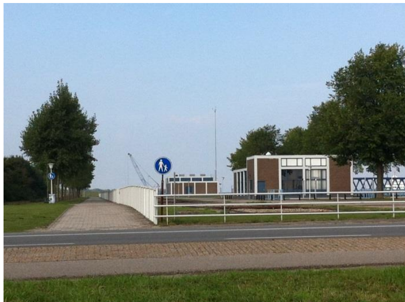
Figuur 3.1 Sluizencomplex Terneuzen
