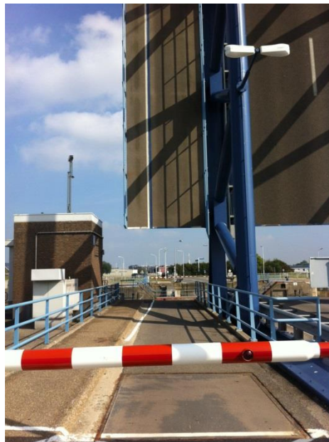
Figuur 1.1 Open brug op het sluizencomplex Terneuzen
