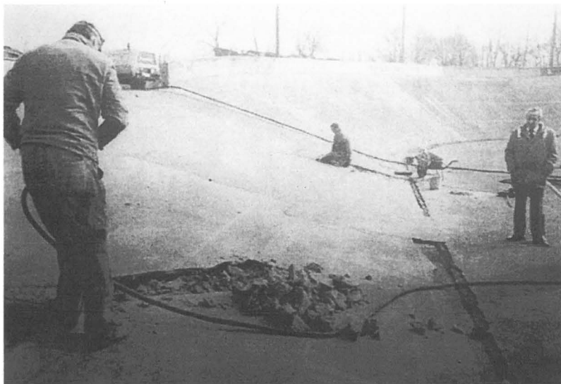
Herstellingen aan betonbaan van vierde wielerpiste §1946-1990)
