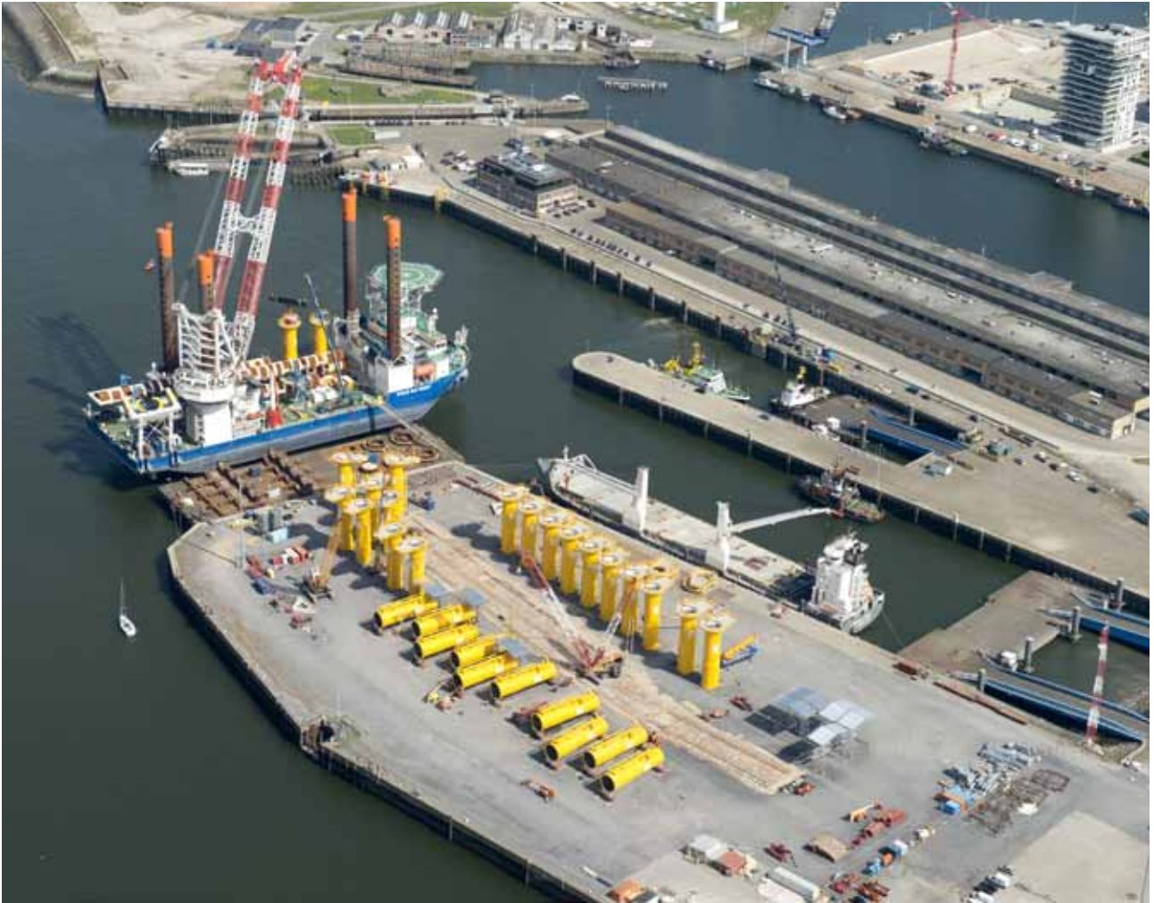
constructie Nobelwind project
