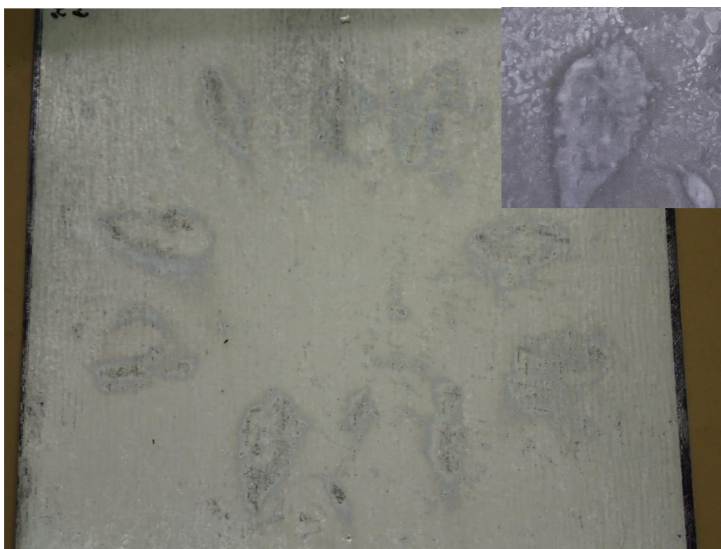
Obr. 8: Poškození zinkové vrstvy
