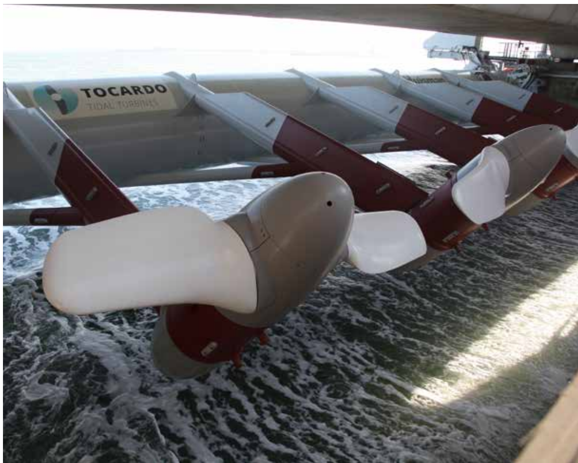
Tocardo T1 tidal turbines in the Afsluitdijk (Netherlands)
