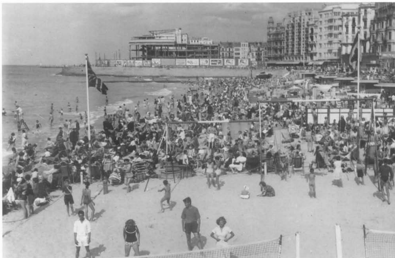
Het Kursaal in opbouw
