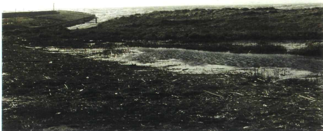
De toegangseul van de slufteer "De Kaloot" in februari 1997.
