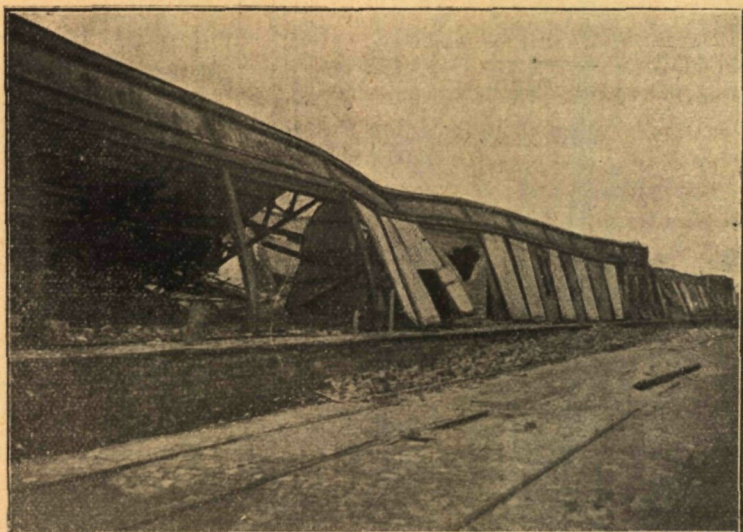
Fig. 1. Hangar IV du môle de Zeebrugge incendié.
