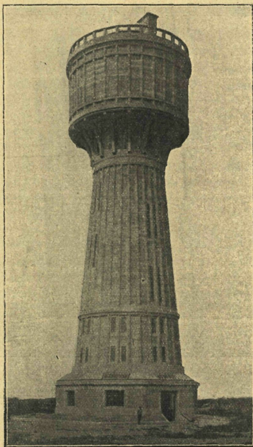
Fig. 4. — Château d'eau de Zeebrugge (reconstruit).
