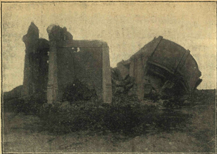
Fig. 3. — Château d'eau de Zeebrugge, détruit par les Allemands.
