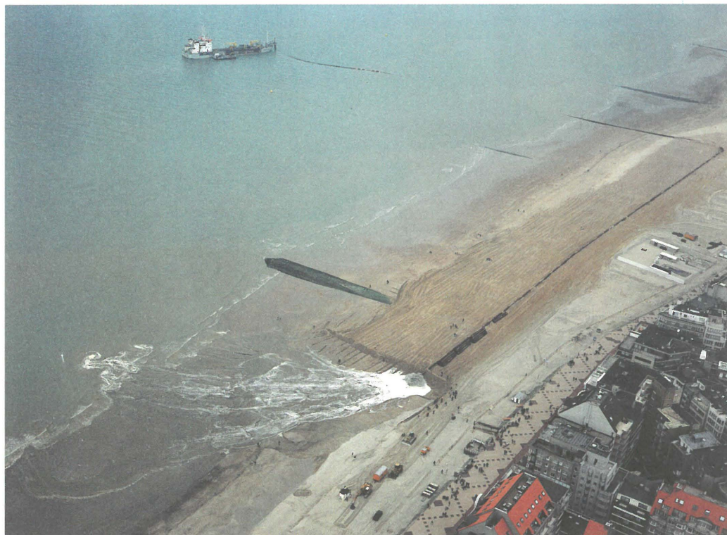
Bij strandsuppleties (zoals hier een strandverbreding te Knokke) pompt een baggerschip vanop zee zand via een persleiding tot op het strand. Op de foto is de persleiding te volgen vanaf het baggerschip tot waar de specie op het strand terecht komt (WWK)
