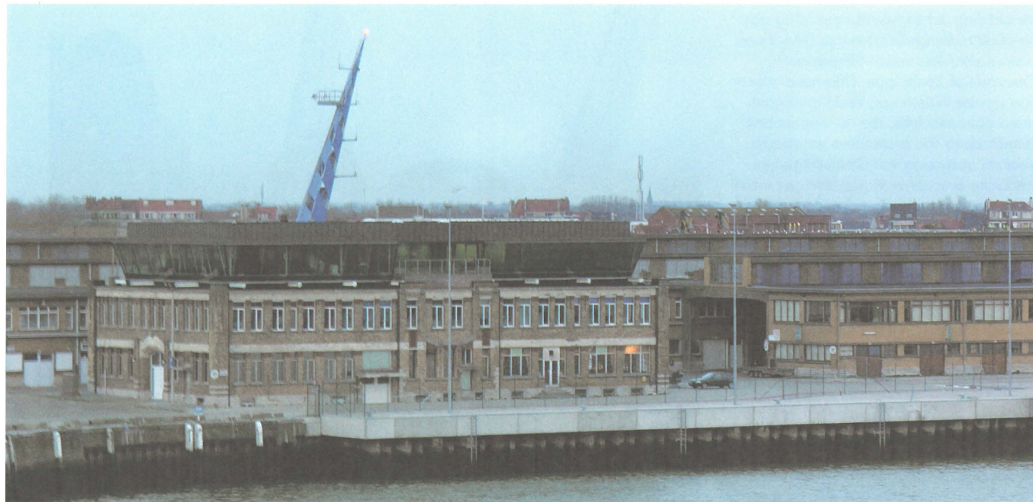
Het MRCC, reeds jaren gehuisvest in de verkeerstoren van de haven van Oostende, was aan uitbreiding en vernieuwing toe. Sinds juli 2006 heeft het MRCC een nieuwe stek gevonden aan de overkant van de havengeul in de gloednieuwe en van de modernste apparatuur voorziene bovenste verdieping van het bestuursgebouw van de vismijn Oostende (VL)
