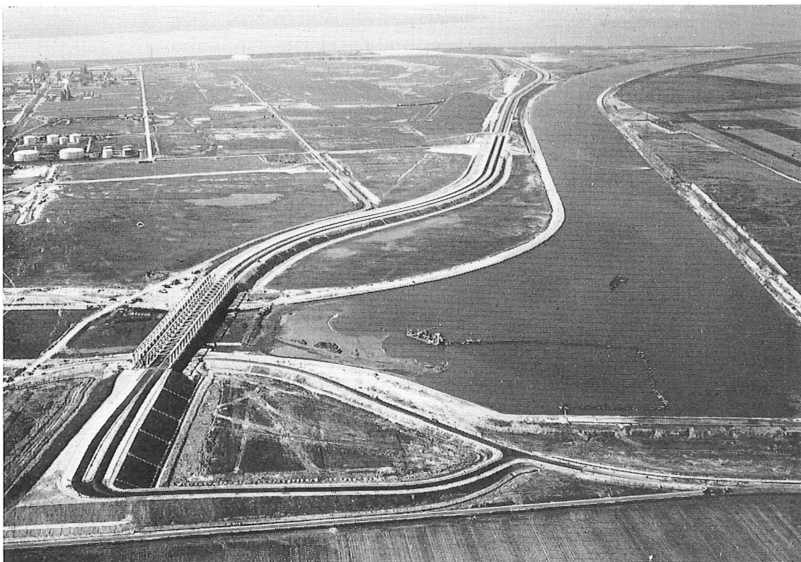
Photo 2. — Vue du bief supérieur à hauteur de la frontière belgo-néerlandaise avec, à l'arrière-plan, l'Escaut occidental. Les travaux de dragage sont en cours (avril 1975).
