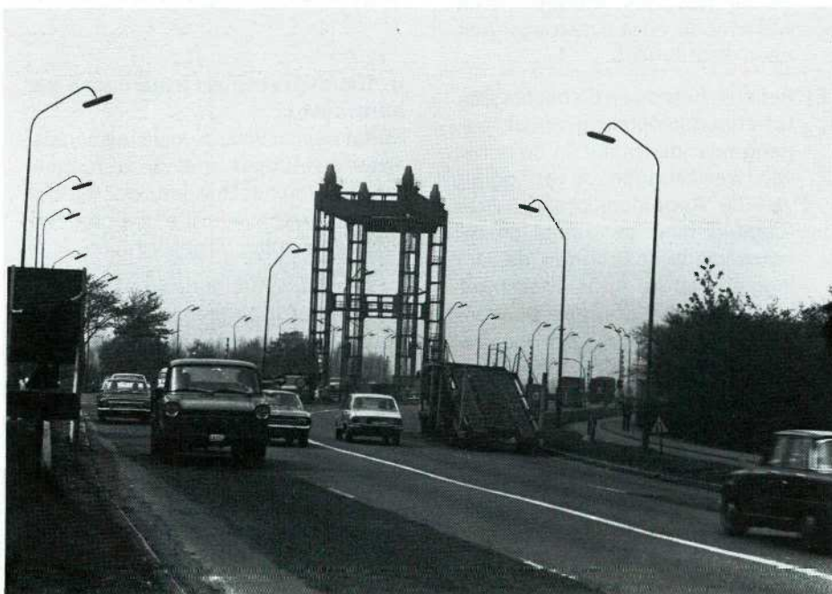
De toestand ter plaatse op 6 juli 1971. Foto genomen richting noord. Op de voorgrond, de beweegbare brug over het Zeevaarkanaal, daarachter de Rupel, en op de achtergrond (noord) de stad Boom. De scheepswerf (met slipway) is goed zichtbaar op de noorderoever van de Rupel tussen de wegbrug (rechts) en de spoorwegbrug (links) (lijn Antwerpen-Dendermonde).
