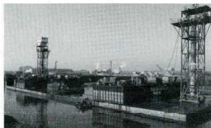
Tunnelement, uitgerust met richttorens en pontons, klaar voor afzinken.
