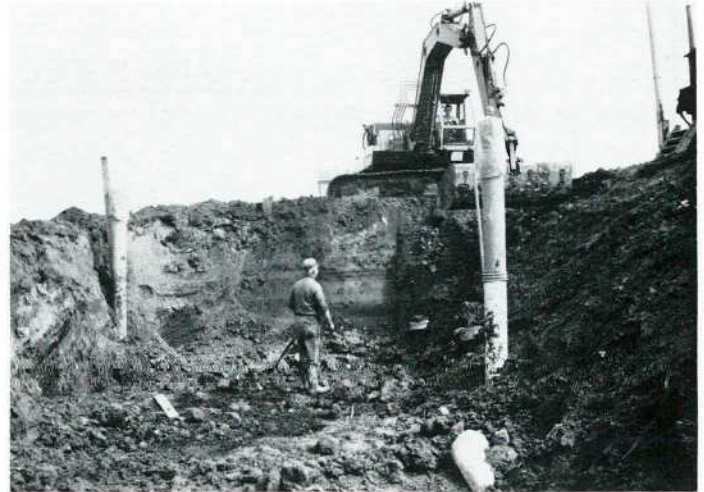
La construction de la trémie entre talus (et non entre murs) entraîne un apport d'eau de pluie tel qu'il a fallu porter la capacité de la station de pompage de 1.000 à 2.500 m 3 .
