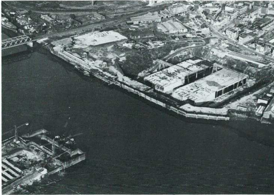
(Photo prise le 24.4.1975) La construction de la cale sèche nord a nécessité la déviation du cours du Bosbeek et la démolition d'importants bâtiments.
