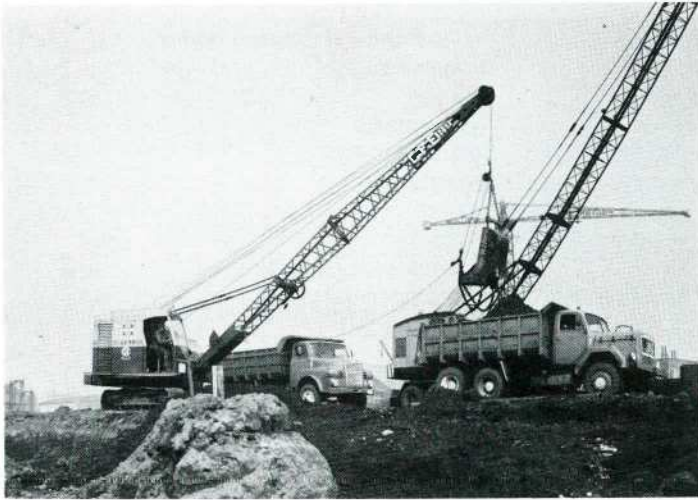
L' ACCES SUD est réalisé par une vaste tranchée qui a nécessité d'importants travaux de rabattement et de terrassement (83.000 m 3 ).
