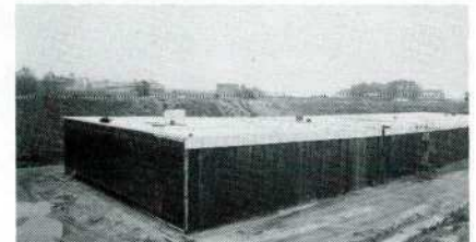
Tunnelement, gebetonneerd in het droogdok.
