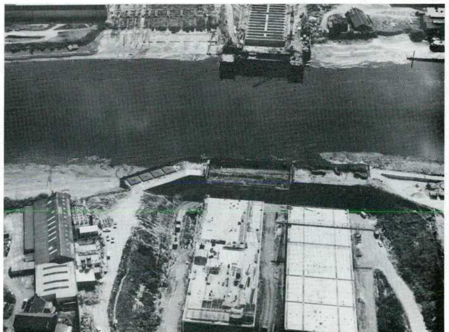
Overzicht der tunnelwerkzaamheden. Op de voorgrond : elementen II en III waarbij II nog in opbouw is. Op de achtergrond : de bovenste rij dwarsbalken die de slibwanden van de in situ tunnel schoren, en in een verdere fase het tunneldak zullen dragen.
