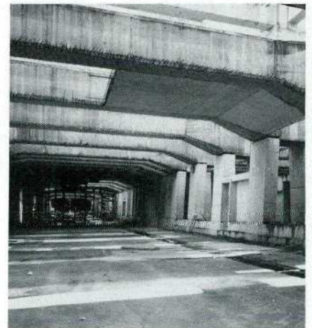
Zicht op het deel tunnel in situ, bestemd voor de rijweg.
