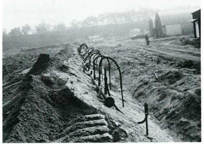
Vue partielle du dispositif de rabattement (21.9.1972). Ci-des-sous, on aperçoit les filtres de grand Ø.
