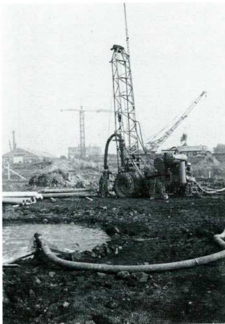
La construction de la trémie entre talus (et non entre murs) entraîne un apport d'eau de pluie tel qu'il a fallu porter la capacité de la station de pompage de 1.000 à 2.500 m 3 .
