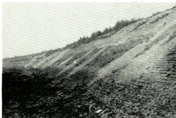
Fig. 45 — Vue d'ensemble de la digue côté Est du bassin, montrant la zone couverte de Crépides (janvier 1960).
