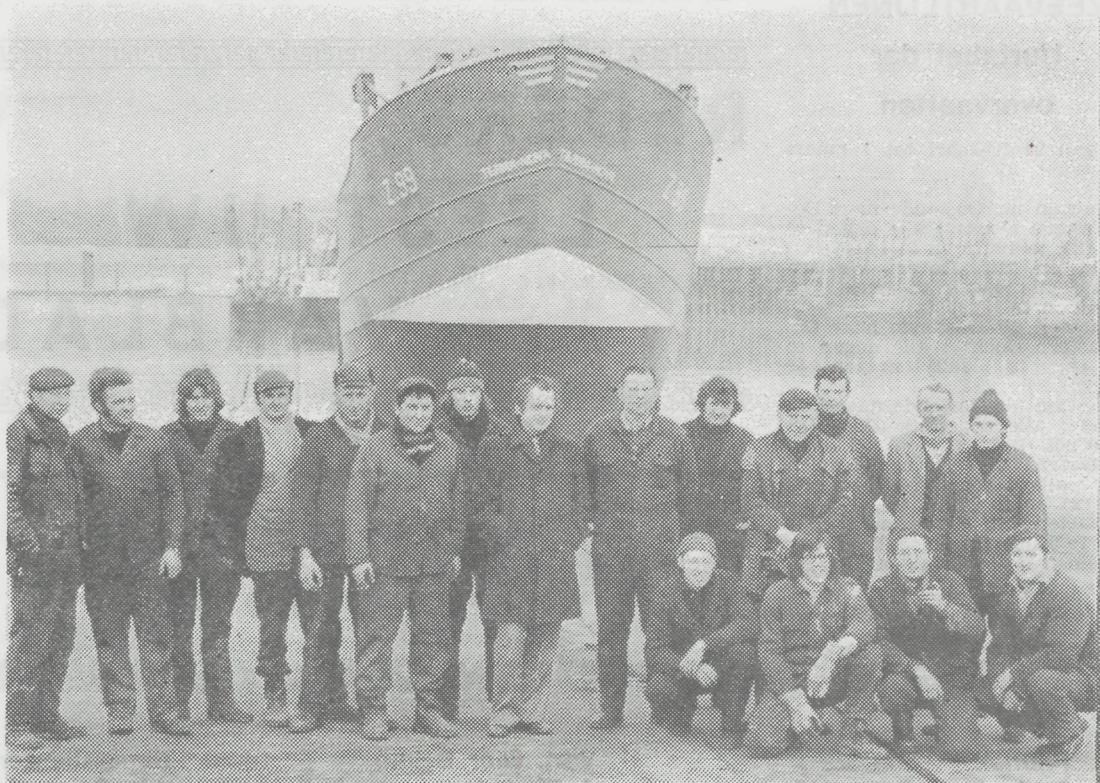
Tijdens het jongste weekeind werd te Zeebrugge de stalen treiler Z.99 «Terra Nova» gebouwd op de scheepswerven Degraeve te water gelaten. Bedoeld vaartuig is in aanbouw voor rekening van reders Roger Degraeve en Leo Coenye. De voortstuwing van deze treiler zal geschieden bij middel van M.A.K.-dieselmotor van 1.000 P.K. De vislierinstallatie zal geleverd worden door de firma Brusselle. De hoofdkarakteristieken zijn de volgende lengte 33,40 m breedte 7,50 m. en holte 4,20 m. (Cliché H.L.N.)
