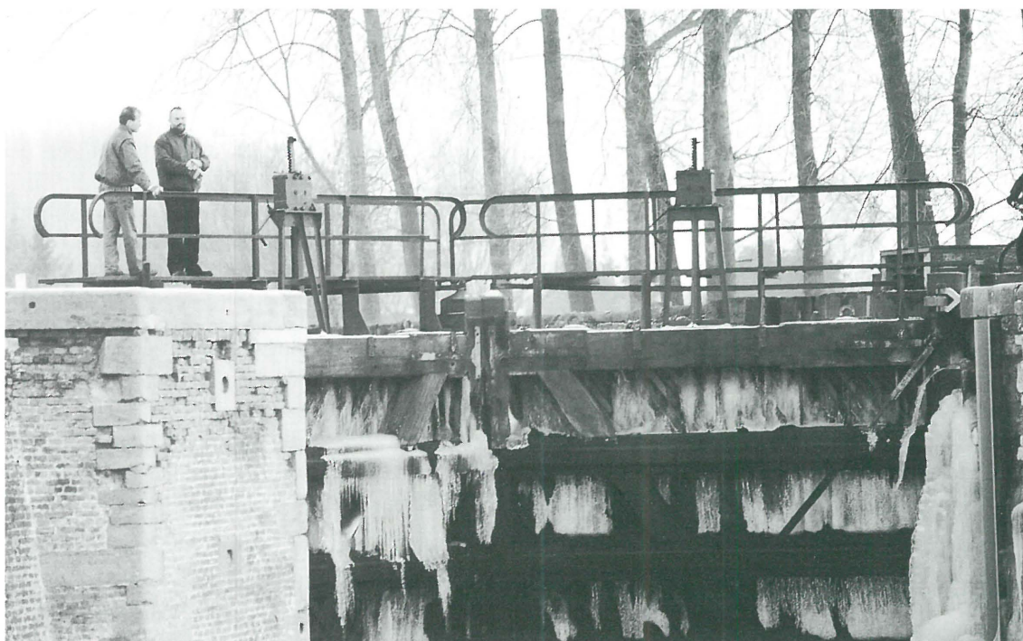
De sluis van Boortmeerbeek: beschermd monument.
