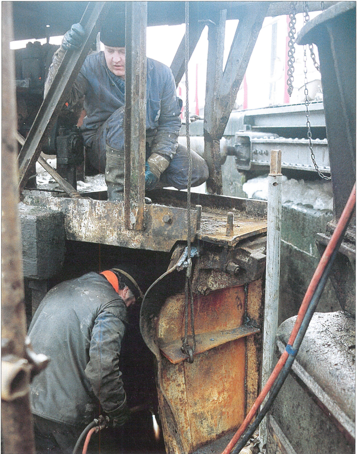
Droogzetten en uitvoeren van herstellingswerken aan de duwvaartsluis te Diepenbeek
