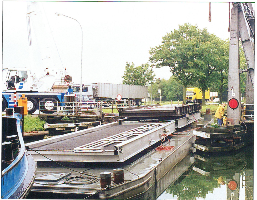
Plaatsen van een nieuw metalen brugval met antislip laag aan brug te Beerse
