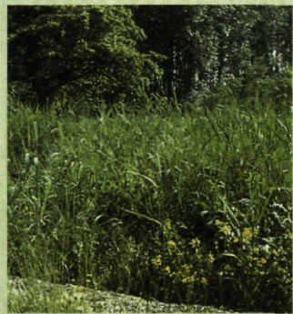
Rietpercolatieveld, gevolgd door een wortelzuiveringszone beplant met diverse bloeiende waterplanten. Deze installatie is gedimensioneerd voor het behandelen van 25 inwoners equivalenten in het natuureducatief centrum te Grimminge (Geraardsbergen).
