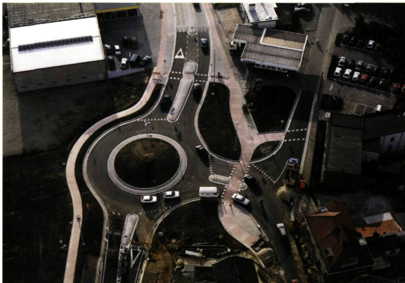
Vrij liggend fietspad bij aanleg van rotonde (Bilzen).
