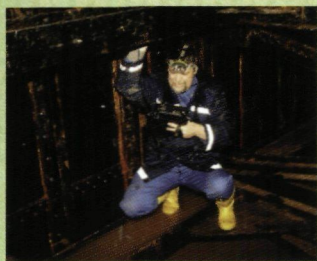
Medewerkers van AOSO voeren inspecties uit naar de technische kwaliteit van allerlei kunstwerken. Hier wordt de dikte gemeten van een draagbalk in de luchtkist van een sluisdeur
