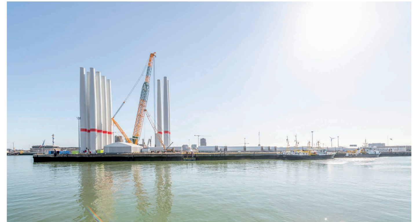
Foto 17: Seamade project vanop de REBO terminal
