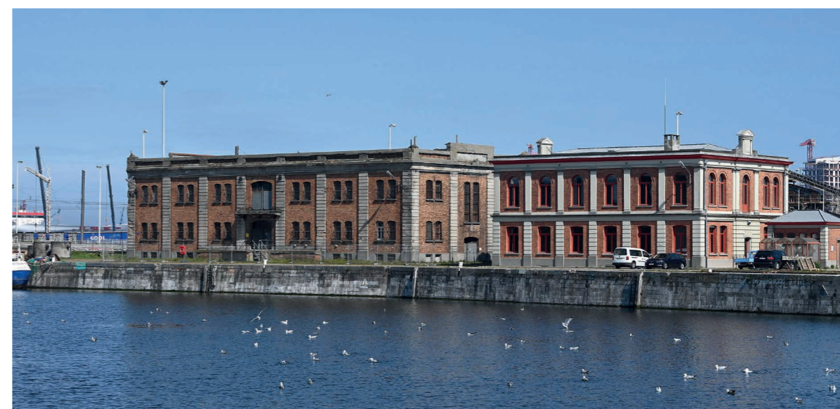
Foto 32: Entrepotgebouw en Douanegebouw
