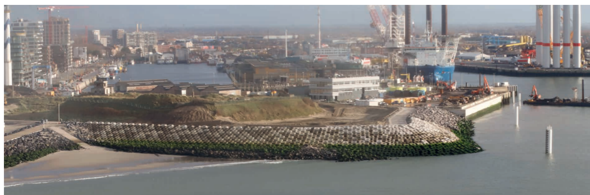
Foto 24: Na de werken aan de site Halve Maan
