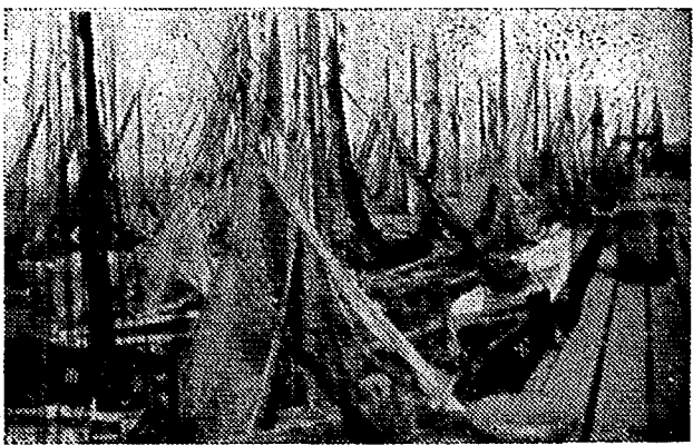
Het houten staketsel van 1907, lengte 100 m.
