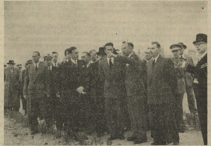
Dhr Molleman verstrekt uitleg aan de Koninklijke Prins over de werking van de sluisen en de slipway. (Foto Michaël)
