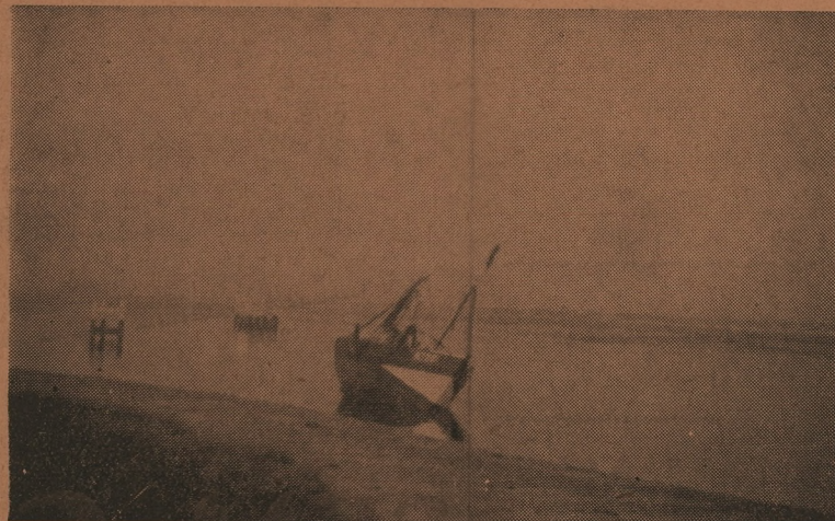
Om dergelijke strandingen bij mist in de haven van Nieuwpoort te vermijden, dient een degelijke verlichting opgericht te worden.
