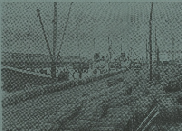
1500 vaten kabeljauwkuit werden vorige vrijdag aan boord van een Nederlandse kustvaarder geladen, met bestemming Frankrijk, voor rekening van de firma Morubel uit Oostende.
