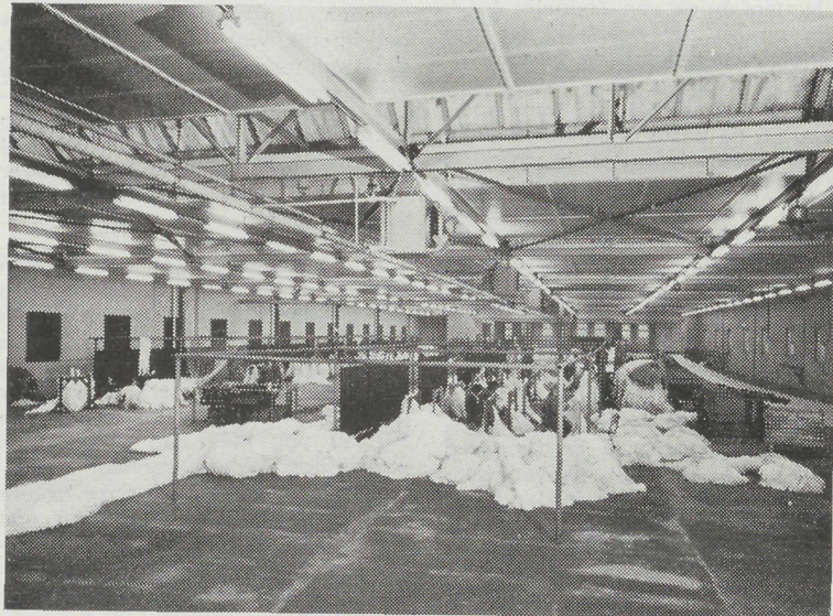
Een blik op een der reusachtige werkplaatsen van de fabriek.
