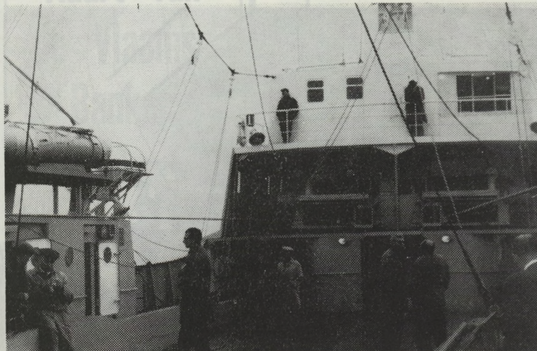
Midships gezien vanaf het achterdek. Rechts het raam van waaruit de schipper alle bewerkingen kan overschouwen. Alle bedieningen zijn daar samengebracht.
