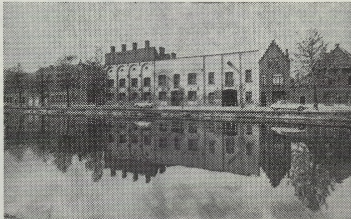
Zo ziet het fabrieksgebouw aan de Coupure er uit. Over enkele weken zal dit vertrouwd beeld definitief verdwenen zijn.
