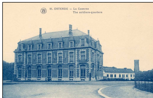
Officiersmess, gebouwd in 1911 (SAO/PK/B870)
