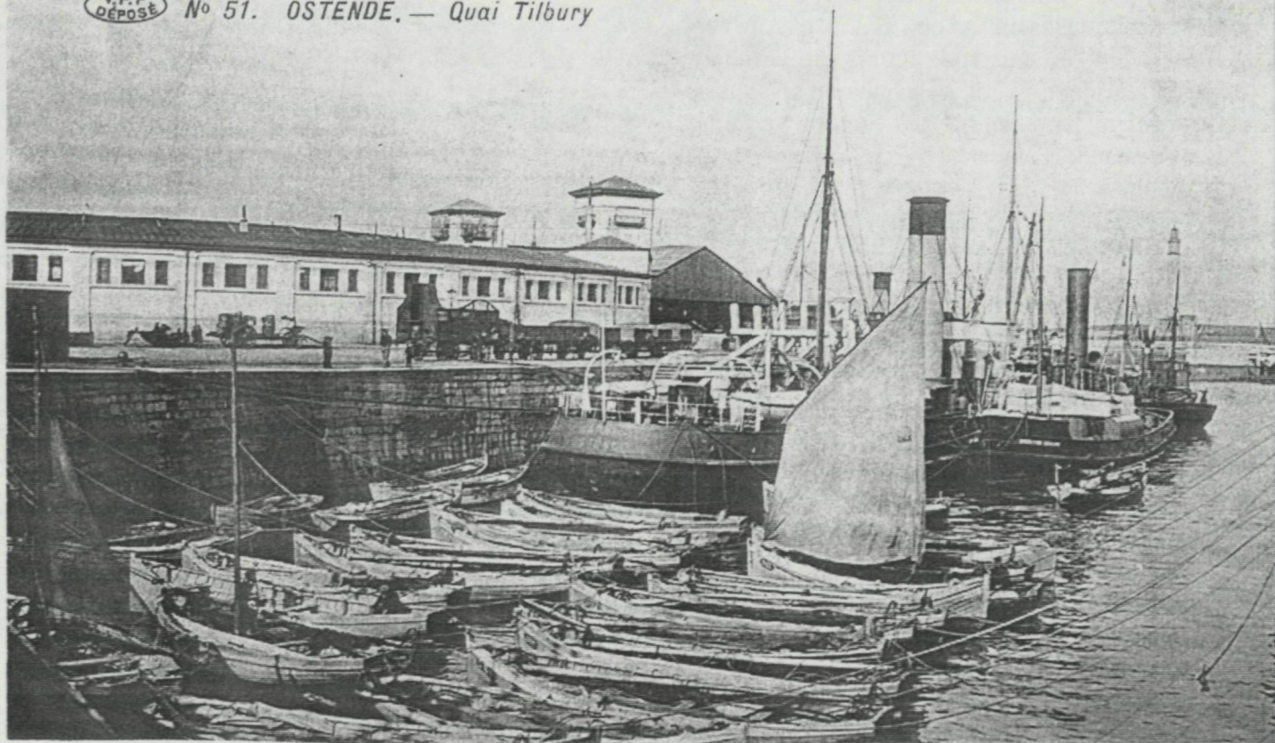
Deze foto uit de jaren circa 1905 toont de TILBURYboot SAPHIR, die tegen de speciaal gebouwde aanlegsteiger ligt in de doodlopende visserskreek. Links ziet men de "cierk", de oude vismijn, met juist ernaast rechts de hangar van de TILBURYlijn. Let ook op de talrijke vissersbootjes van de "bootjesjouters" uit die tijd.
