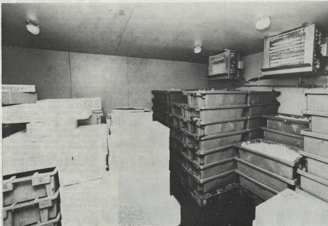
Een binnenzicht van de koelkamer die duidelijk de grote opslagruimte en mogelijkheden aantoont. (Foto NVDK - Herman)
