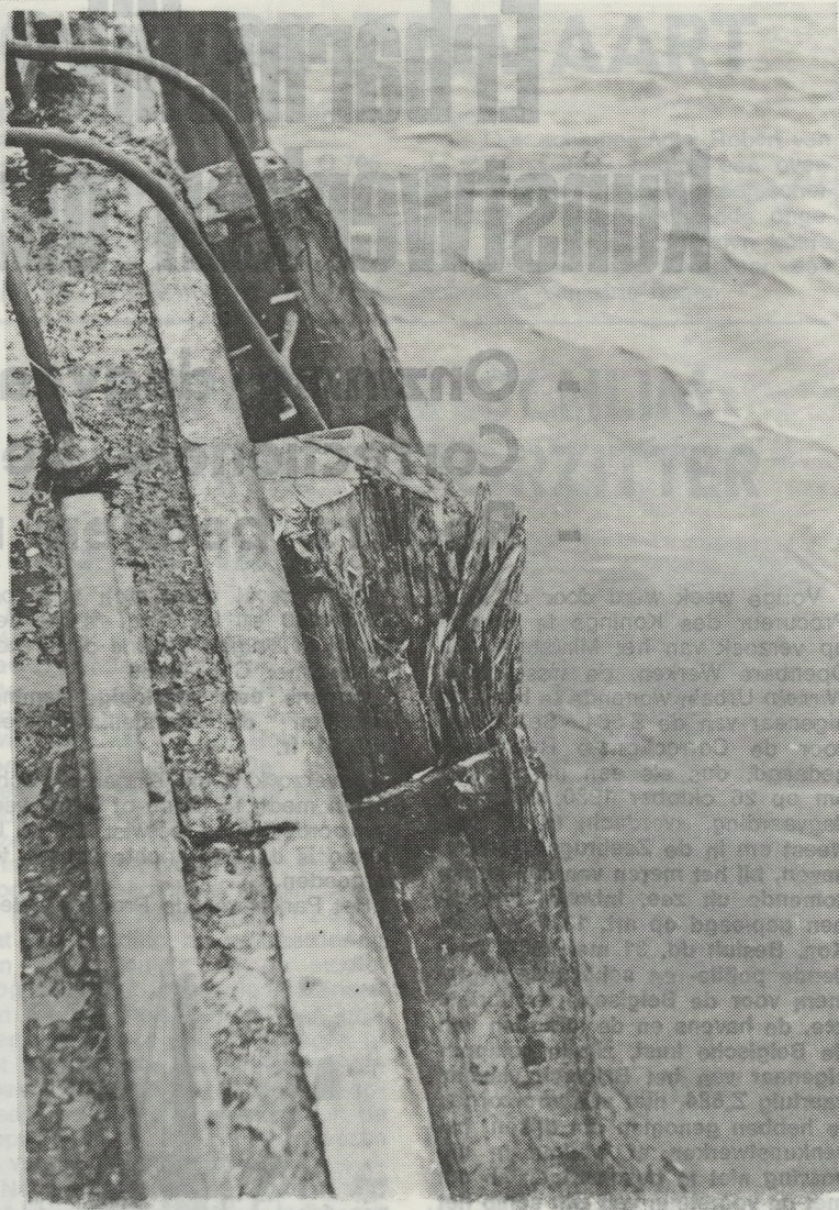
De toppen van de wrijfhouten zijn totaal verrot maar de verantwoordelijke diensten bekommeren zich daar niet om. Een of andere reder zal t.g.t. de schade wel vergoeden.
