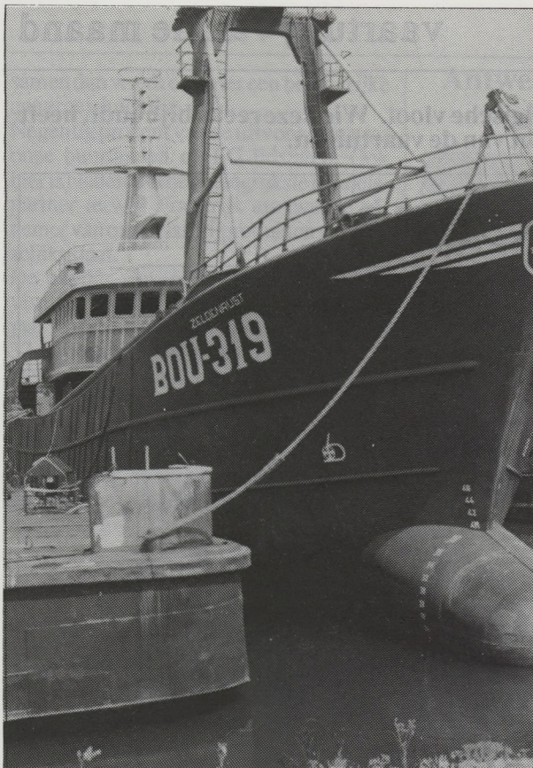
De werken aan de nieuwe bokkentreiler BOU.319 met een lengte van veertig meter (ter vervanging van de Z.319 'Philadelphian') op de werf Maaskant in Stellendam zijn al vergevorderd.
