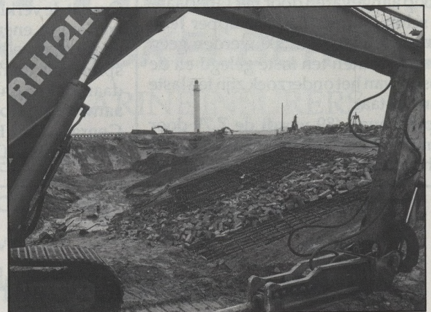
De eerst matten zijn reeds geplaatst en ook met het storten van recuperatiemateriaal als versterking is reeds begonnen. (foto's gw)
