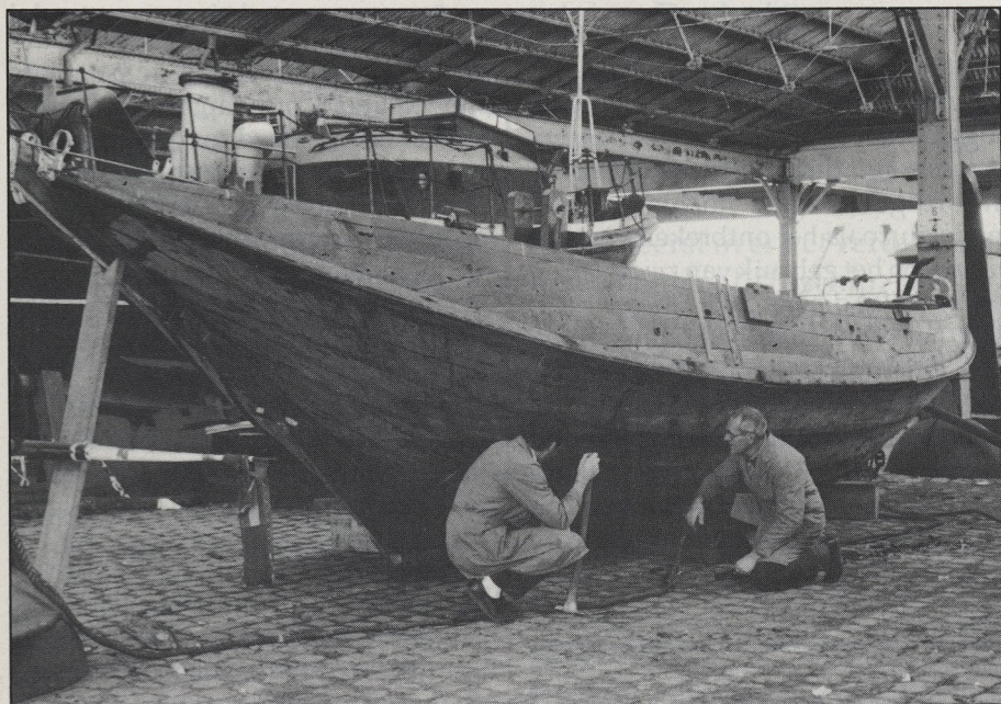
In het Antwerps scheepsvaartmuseum wordt systematisch kennis over de houten scheepsbouw opgedaan en doorgegeven aan een jongere generatie scheepstimmerlui. Op de foto onderzoeken hoofdrestaurateur Kaak en scheepstimmerman Thys de huidgangen van het hoogaarsjachtje 'Dolfijn'.
