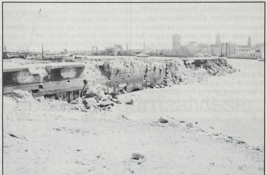
De zeewering tussen de Staketselstraat en de Havengeulkaai hield vroeger 70% van het stormgeweld tegen. Nu deze muur afgebroken is is de haven compleet blootgesteld aan het stormgeweld. (foto dp)
