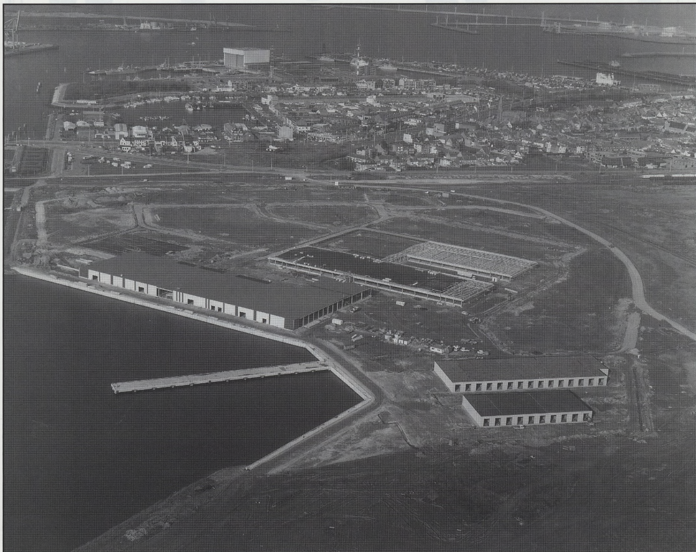
In 1992 (foto) werd er nog volop gebouwd aan het vastgoed van de nieuwe Zeebrugse Visveiling. Nog geen vijf jaar later werd datzelfde vastgoed al verkocht. (foto Henderyckx)
