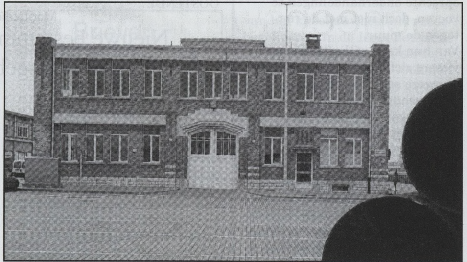
Het bestuursgebouw van de vismijn wordt gerenoveerd en krijgt een glazen bovenbouw voor de maritieme verkeersleiding. (foto gw)
