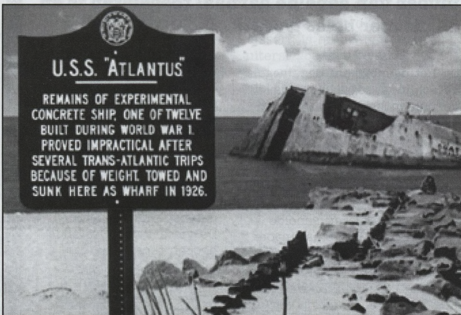
Het betonnen schip SS Atlantus (250 voet lang, 2.500 ton, snelheid 102 knopen) werd op 5 december 1918 (telaat om deel te nemen aan WO I) te water gelaten. Het werd verkocht en gebruikt voor kolentransport. Nadien zou het een bestemming krijgen als ferry, maar het schip liep vast vlak tegen Sunset beach , Cape May , New York . Daar is het sindsdien een beroemde toeristische attractie.
