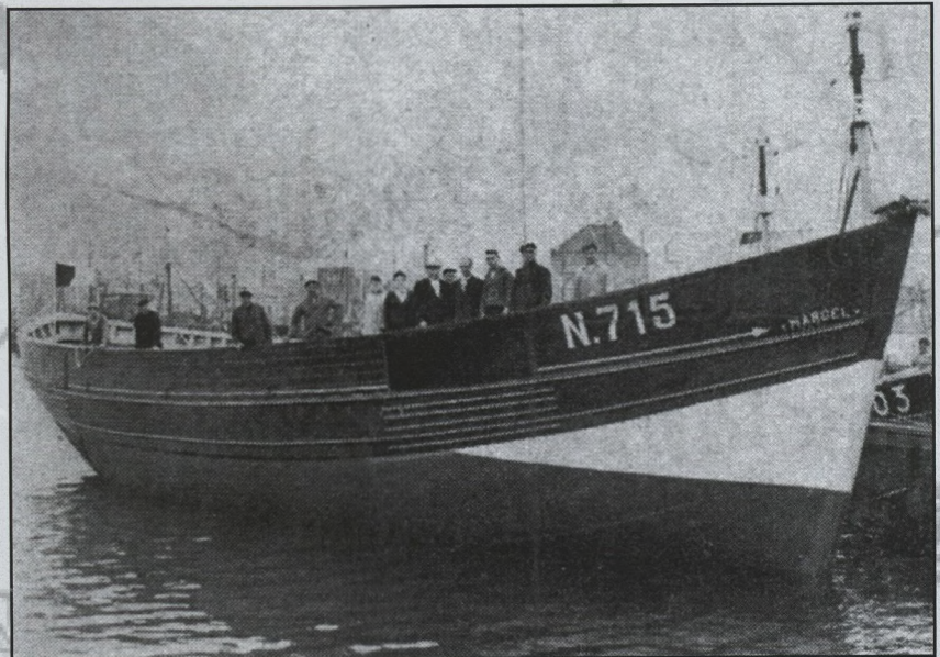
Casco N.715 klaar - Op de werf van Achiel Hillebrandt te Oostende ging op 13 september het houten casco voor de N.715 Marcel te water. Opdrachtgever voor de bouw van het 18 m. lange kustvaartuig is Marcel Depotter uit Nieuwpoort
