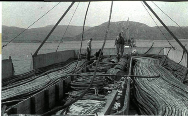
Het leggen van de TAT 1 kabel aan boord van de HMTS MONARCH
