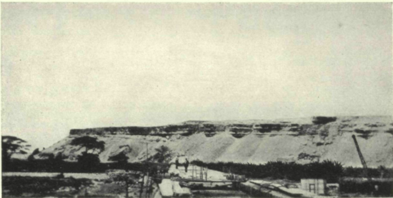
Fig. 17. — Vallée du Giraul près de Fazenda Giraul. Pont du chemin de fer de Sa de Bandeira (Ponte Governador Silva Carvalho) Eocène mis en relief sur le dessus, avec blocs éboulés, Paléocène dissimulé par les déblais de désagrégation. (Photo M.A. DE PIMENTEL TEIXEIRA, Moçâmedes, 1949).
