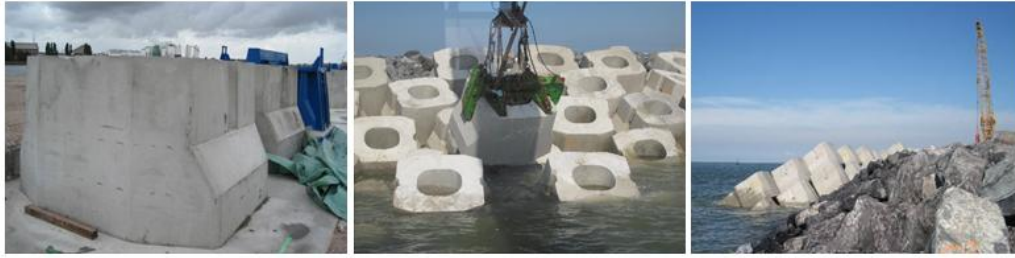
Figuur 6-8 HARO-elementen (bron: https://www.maritiemetoegang.be/havendammen-en-radartoren-oostende )
