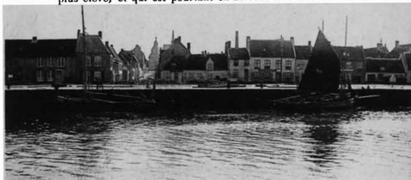
15. Le port de Nieuport Ville.
