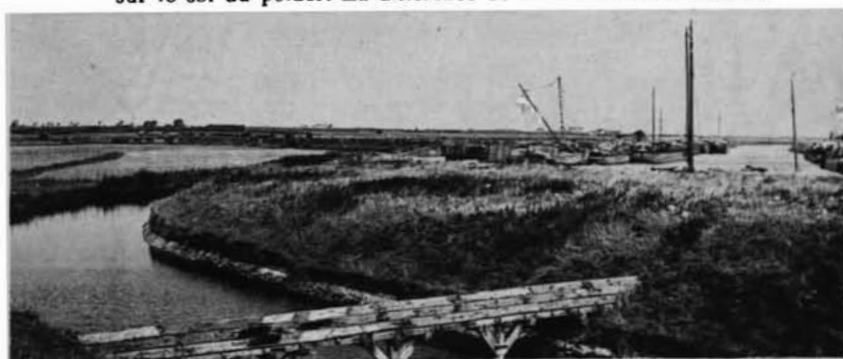
14. A gauche, l'ancien canal de Vladsloo, qui est au niveau du polder - A droite, le canal de Plasschendaele, qui est de 2 mètres plus élevé, et qui est pourtant en-dessous des mares hautes.
