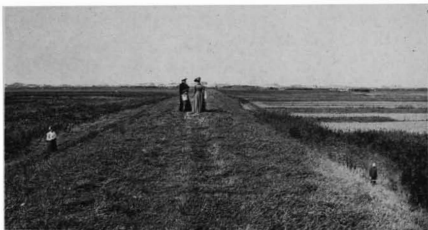
13. Digue séparant la schorre du polder. La jeune fille, à gauche, se trouve sur la laisse de marée haute ; le garçon, à droite, est sur le sol du polder. La différence de niveau est de 2 mètres.
