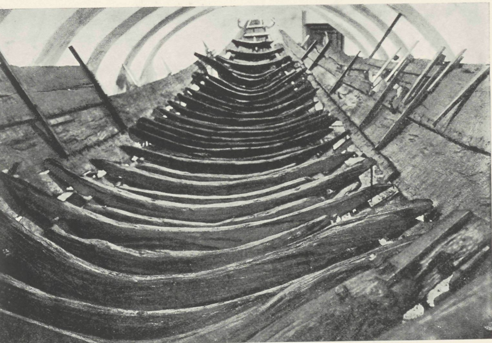
Binnenzijde van het Utrechtsch Schip, tijdens de restauratie, gezien van achter naar voor.
