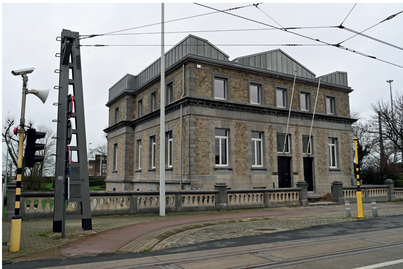
Foto 39: Havenkapiteinsgebouw na renovatie
