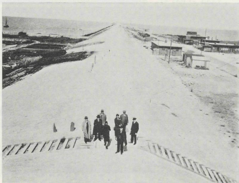
4. La grande digue
