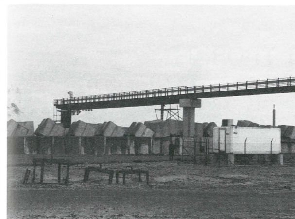
Foto 2. — De meetopstelling „Daminstrumentatie” op de Westelijke dam.
