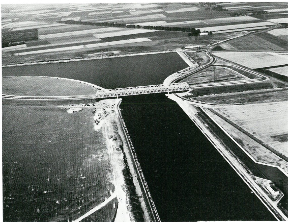
Photo 1. — Vue du canal au départ d'Anvers. On remarque les ponts jumelés (chemin de fer et route) de Zandvliet ainsi que l'amorce du futur canal Zandvliet-Oelegem. (Photo Barthofmeester - Rotterdam).
