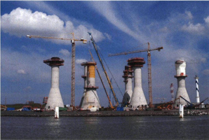
funderingen in beton (GBF) voor de 1 e 6 windmolens in het C-Power park
