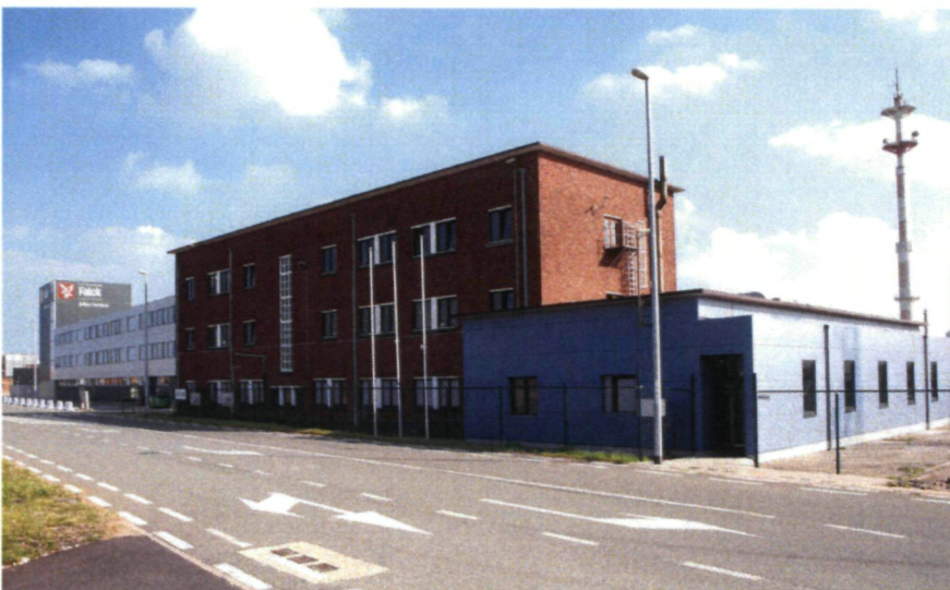
gerenoveerd gebouw voor Servion met directe toegang tot de kade
