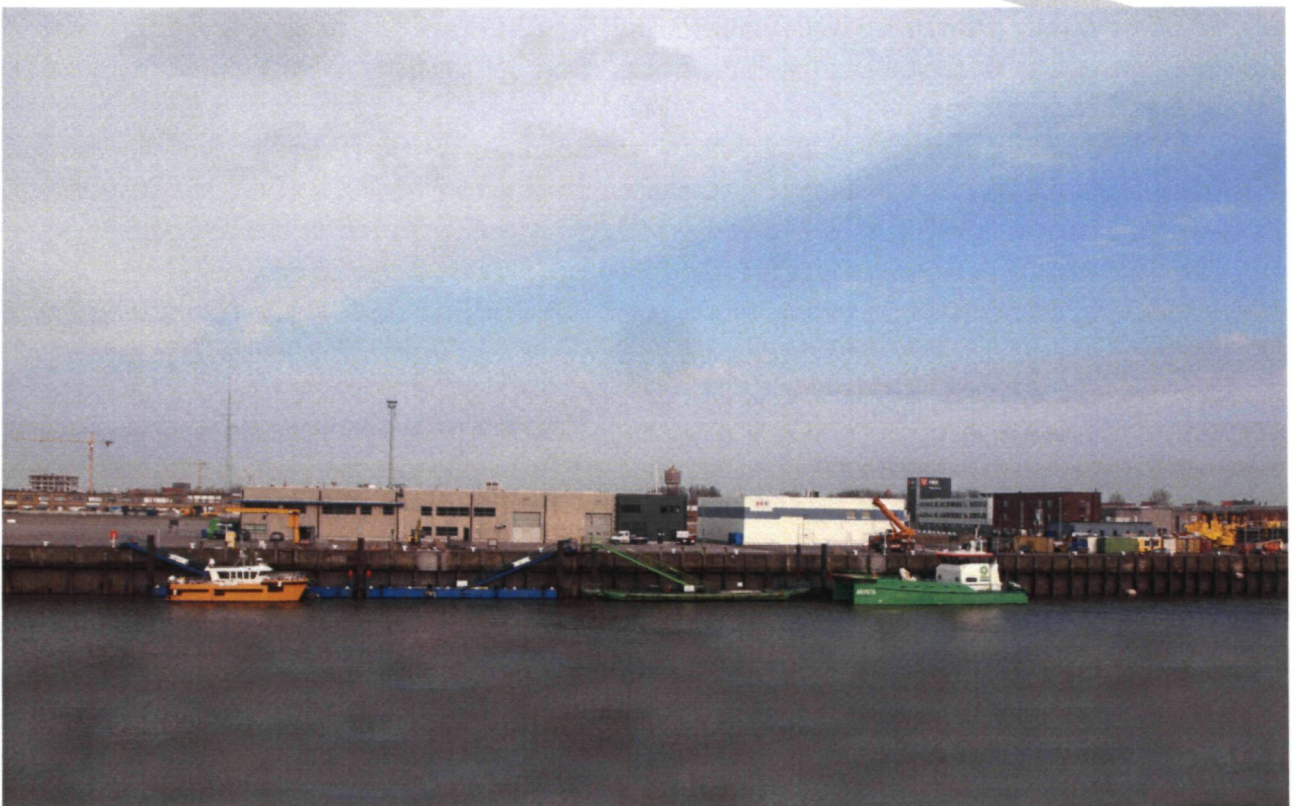
de pontons voor de service vessels zijn uitgerust met walstroomvoorziening
