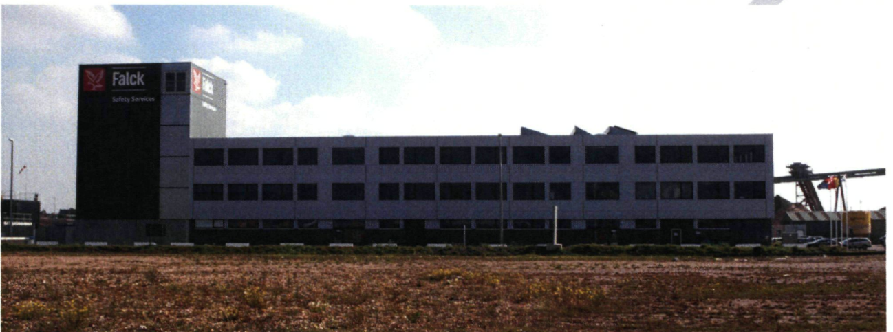
gebouw voor o.a. Falck Safety Services met directe toegang tot de kade
